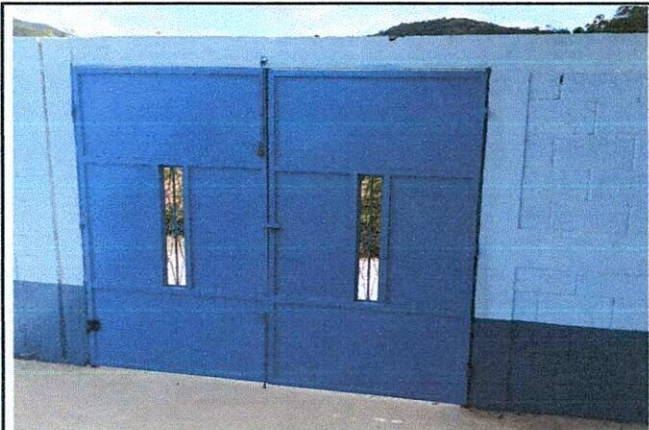
Foto 4: SUSTITUCIÓN DEL PORTÓN.
